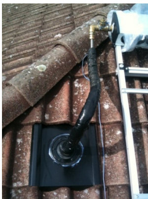
Eksempel på takgjennomføring
