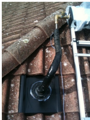
Przykładowe poprowadzenia rur przez dach
